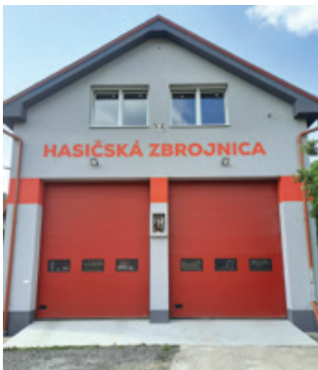
Finálna rekonštrukcia Hasičskej zbrojnice
