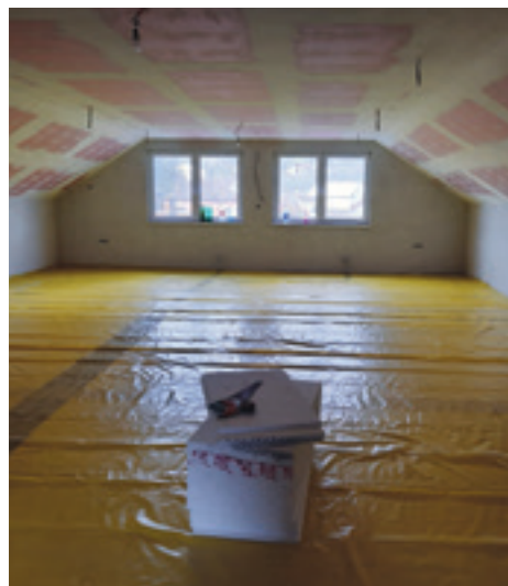
Dokončovacie práce na podkroví hasičskej zbrojnice
