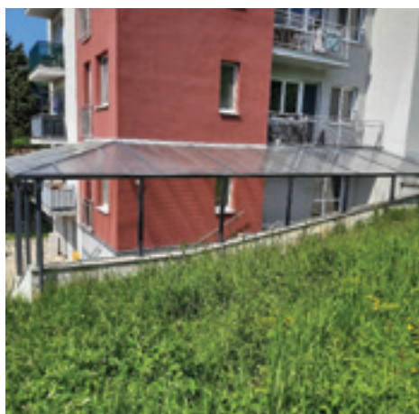
Zastrešenie vonkajšieho schodiska bytového domu č.705
