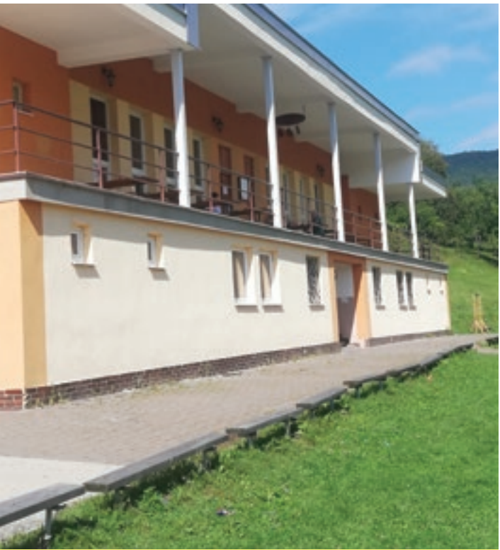
Statické zabezpečenie prestrešenia budovy na ihrisku
