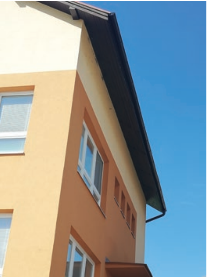
Montáž snežníkov a výmena žľabov na budove OcÚ
