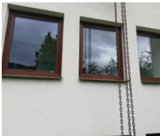
Výmena okien prebehla na dome smútku.
