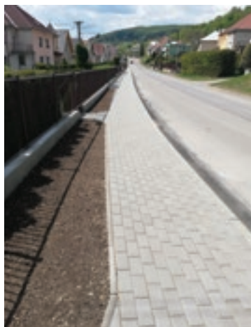
Dokončená 4. etapa rekonštrukcie chodníka v lokalite Kanál.
