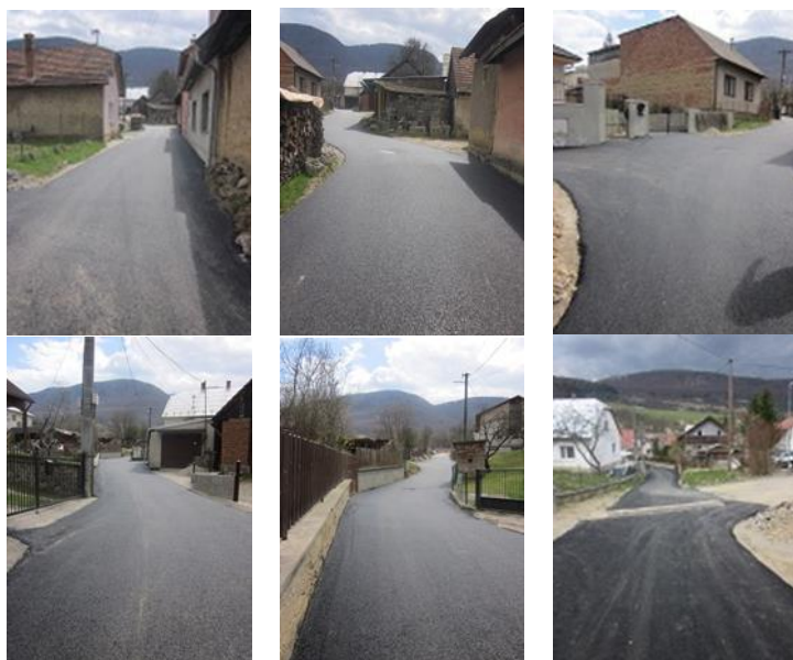
Fotodokumentácia z vyasfaltovanej cesty od kostola smerom ku Dvorským
